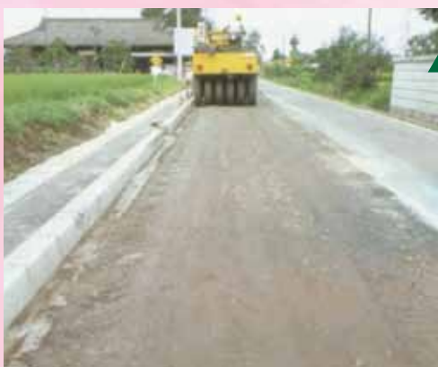
タイヤローラ、鉄輪ローラによる締固め
