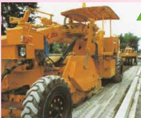
ディープスタビライザによる破碎とアスゾル A の混合
