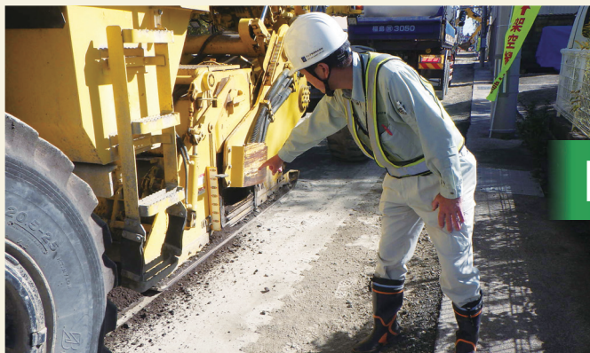
発注者は現場立会による品質確認
