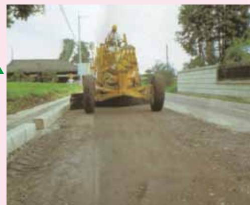
仮転圧後のモーターグレーダによる整形
