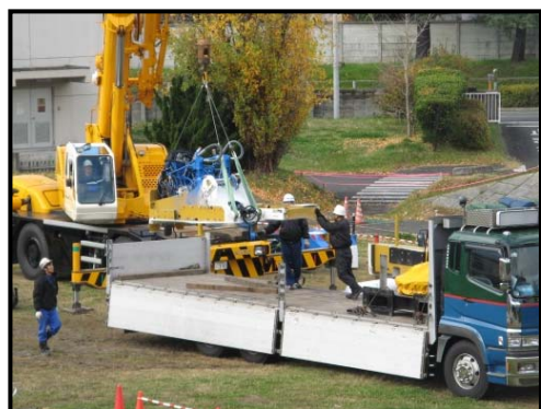
【25tラフタークレーンによる積み込み・積卸し作業】
