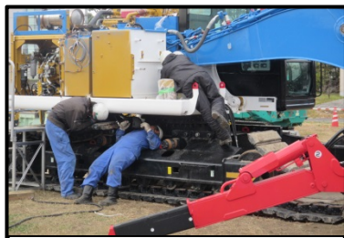
パワーユニットと下部旋回フレーム の配管接続作業
