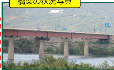
橋梁の状況写真
