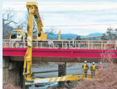
点検車による橋梁点検
