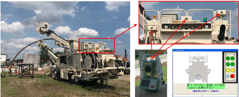
マシン姿勢測定用プリズム（3箇所）自動追尾測量機 ナビ画面表示 「支保工位置ナビゲーションシステム」詳細
