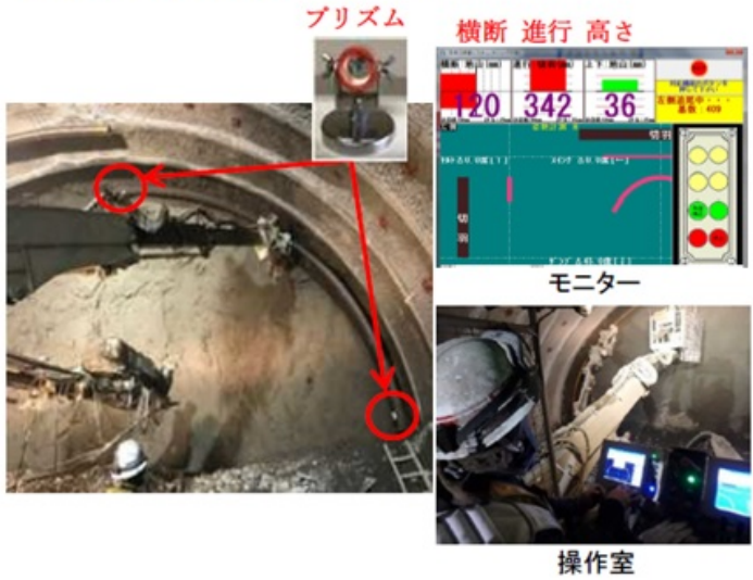
【右側鋼製支保工位置合わせ状況】
