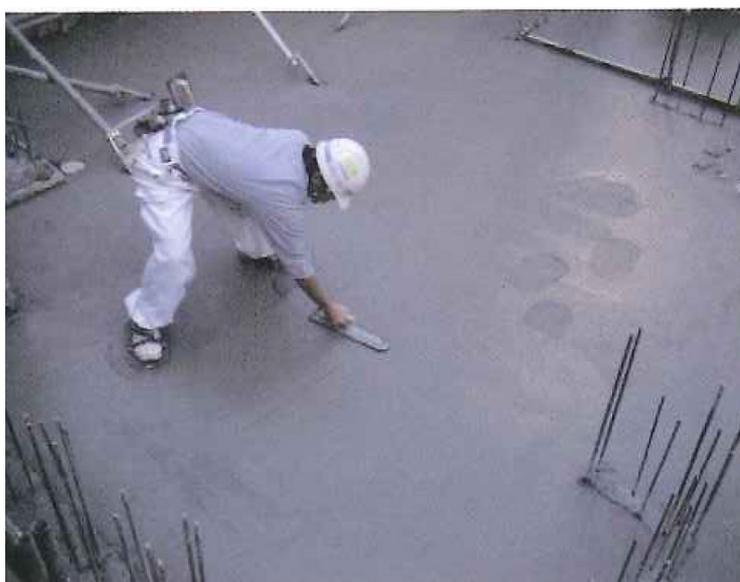
図 仕上げ作業状況の例
