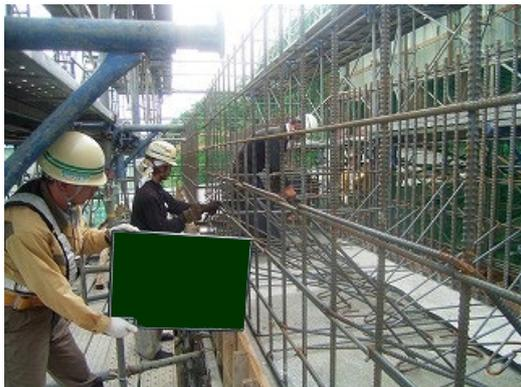
図 施工者による鉄筋組立確認状況
