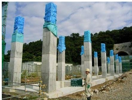
図 鉄筋露出部をブルーシートで保護した例（高架橋における柱とスラブの接合部）
