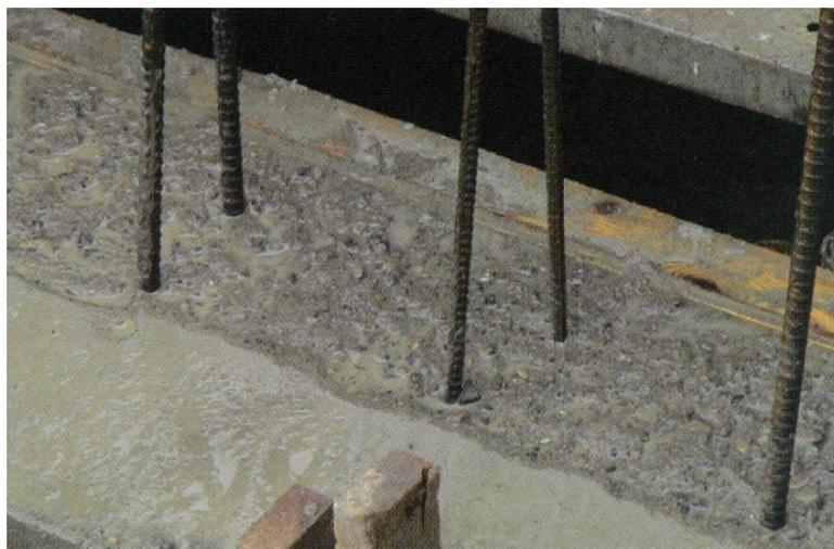
図 打継ぎ処理部の給水例<sup>9)</sup>
