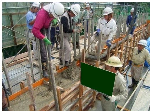
図 施工者によるコンクリート締固め確認状況
