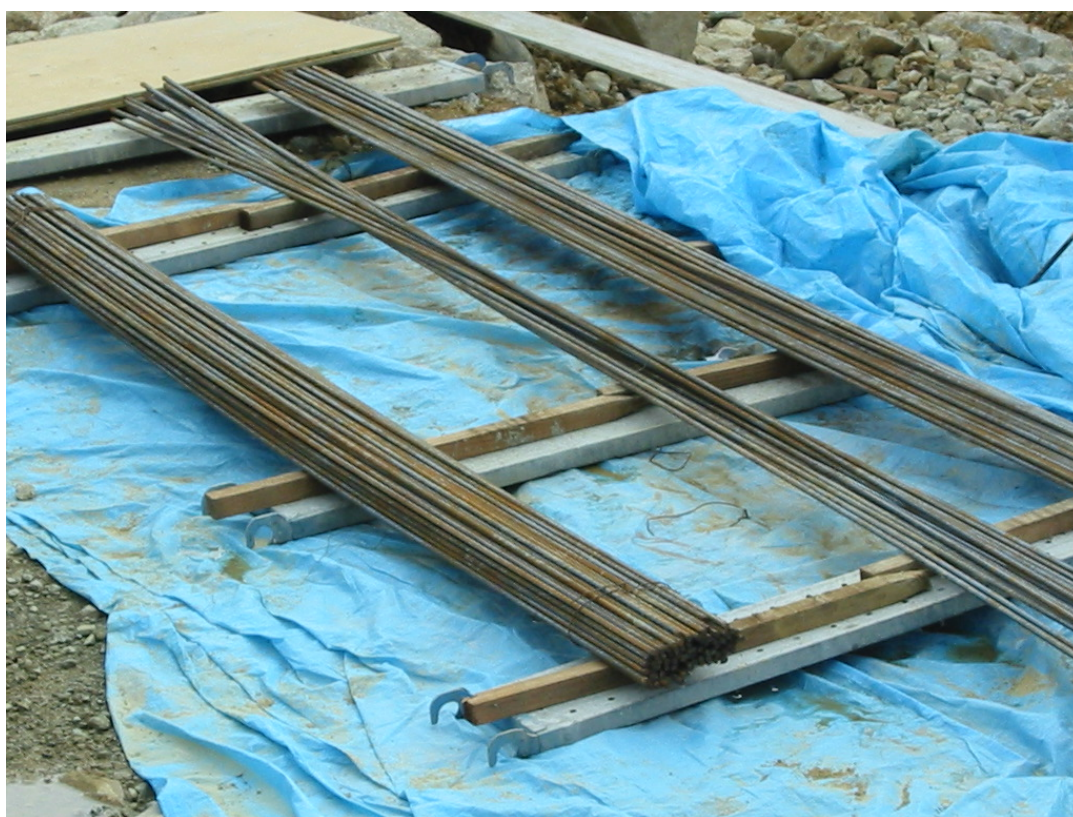
写真 3-1 鉄筋が地面と接しないような処置
