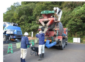
写真 6-1 トラックアジテータからの採取
