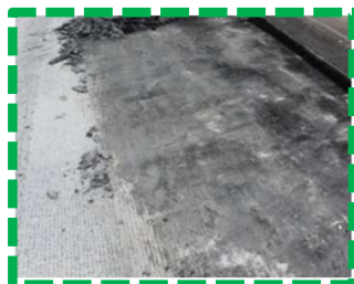
剥ぎ取り後の状況
