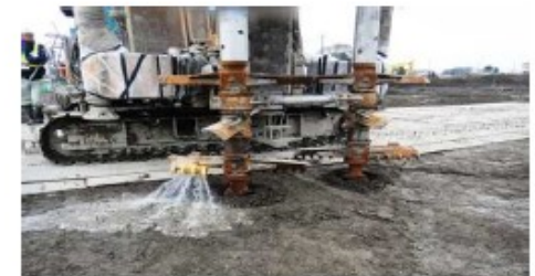
新型攪拌翼とエジェクター吐出口
