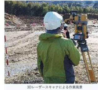
本技術は地上型3次元レーザースキャナを使用した非接触の形状計測システムである。従来はプリズムを使用したトータルステーションによる計測で対応していた。本技術の活用により、プリズムが不要で作業員1人で作業が出来るため、労務費が削減され経済性の向上が図れる。
