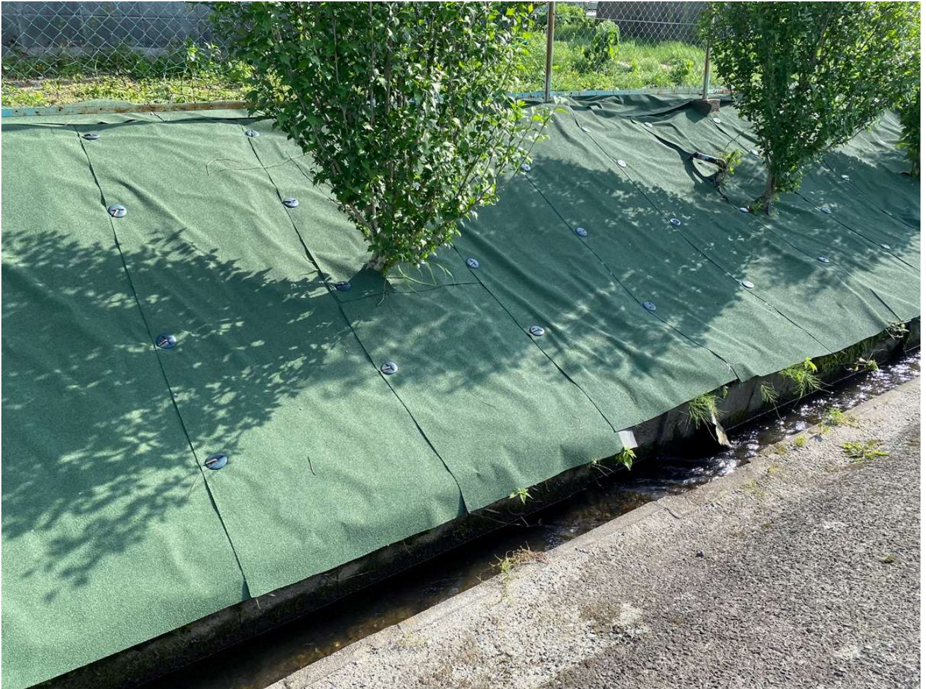
ハヤサンS20施工写真
