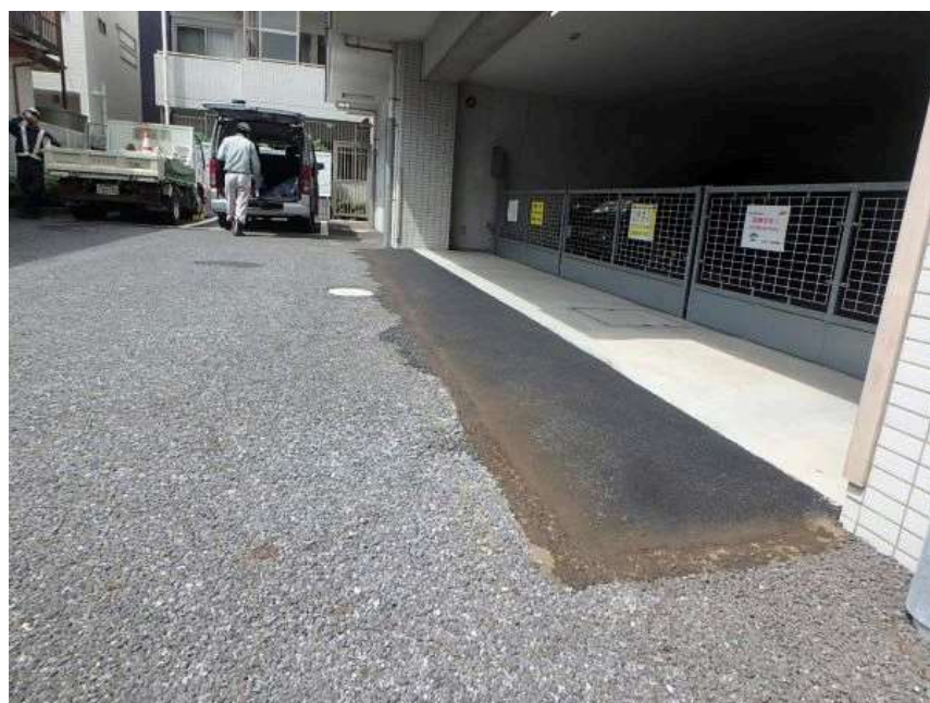
TRミックスアクア施工例「段差摺り付け」
