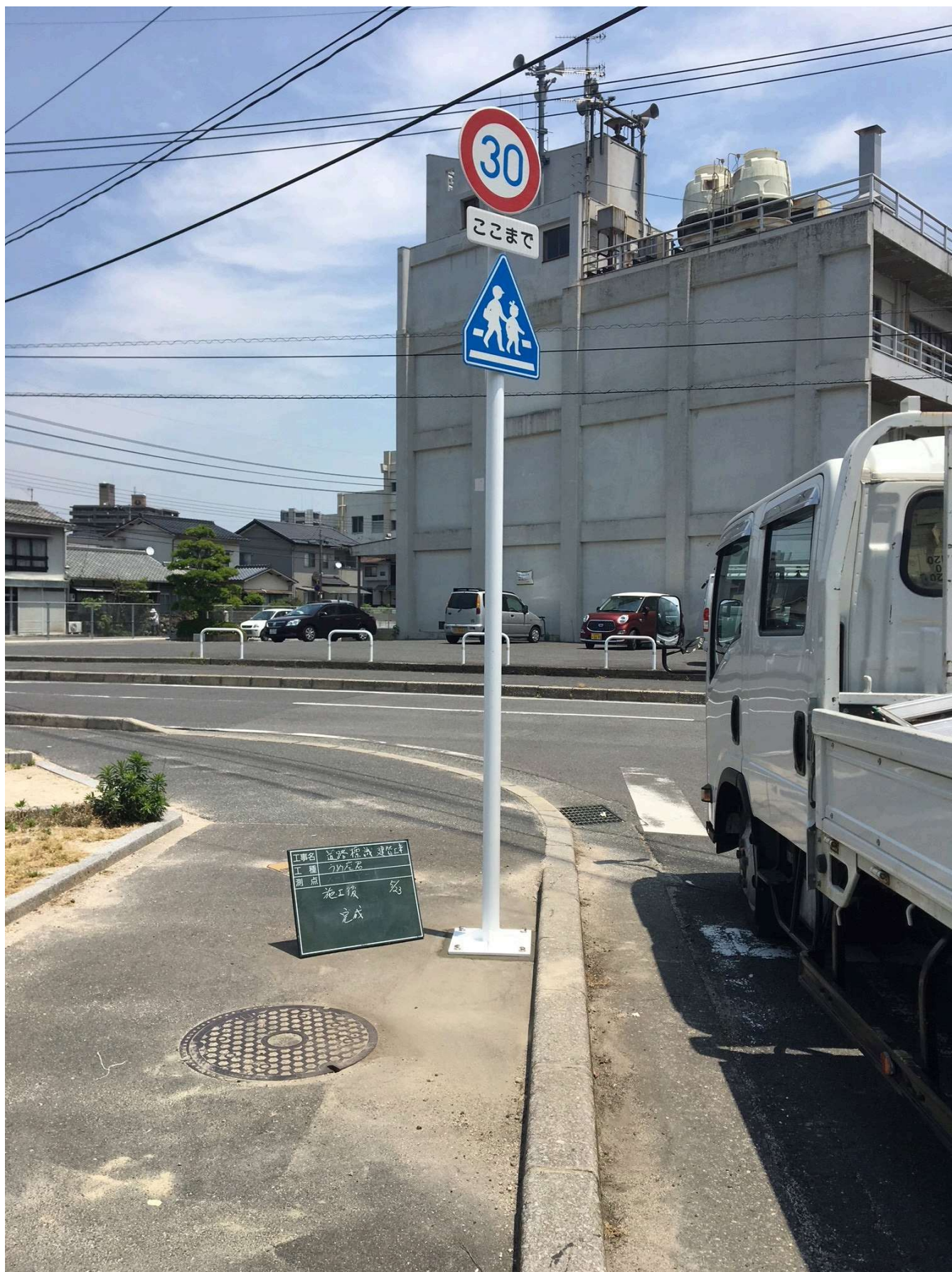
道路標識設置工事：大竹警察署
