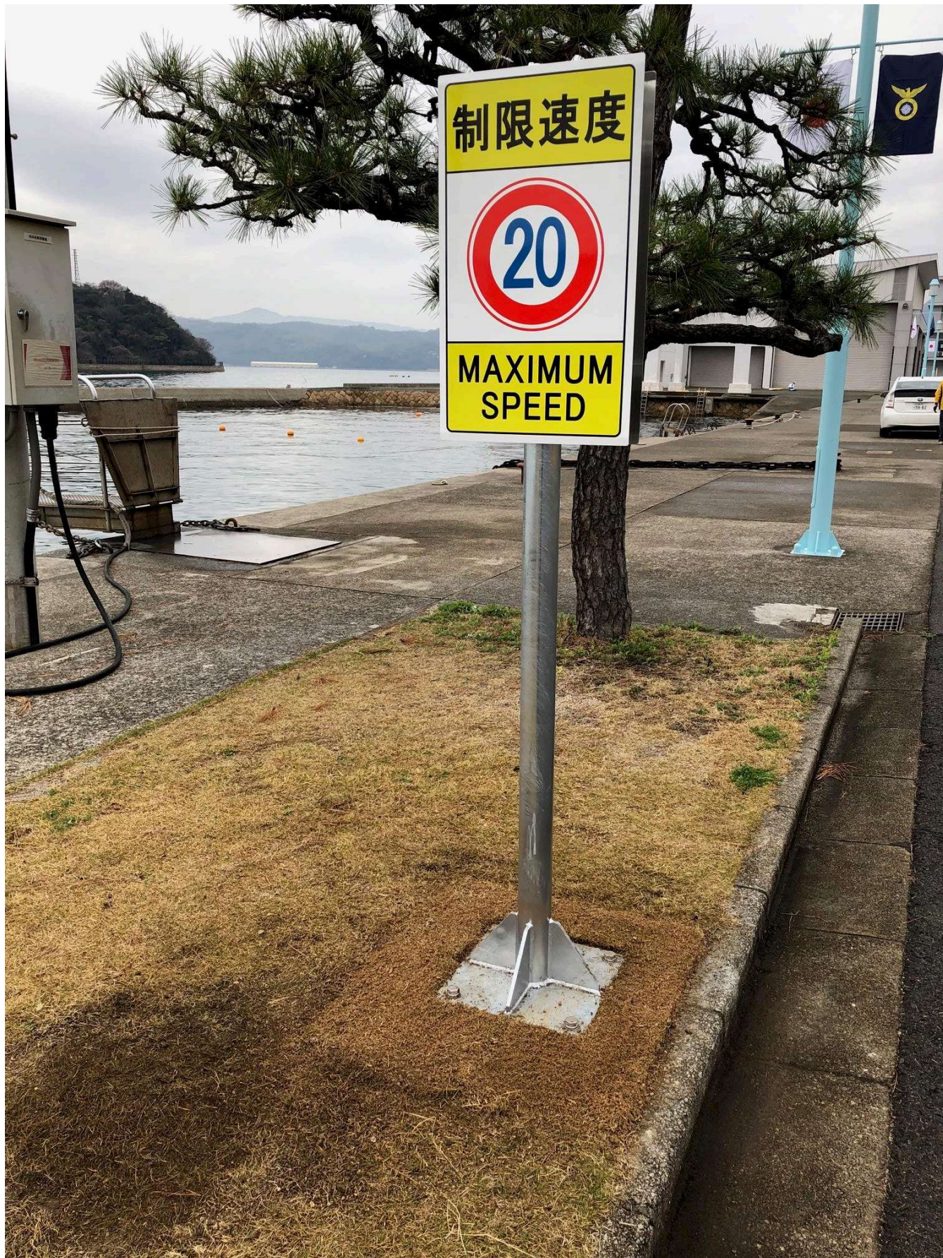
道路標識設置工事：海上保安大学校
