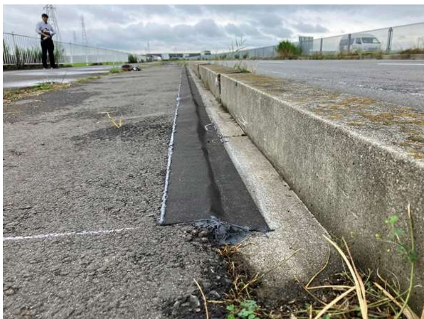
施工事例（愛知県）
