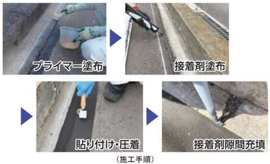
標準断面および施工手順
