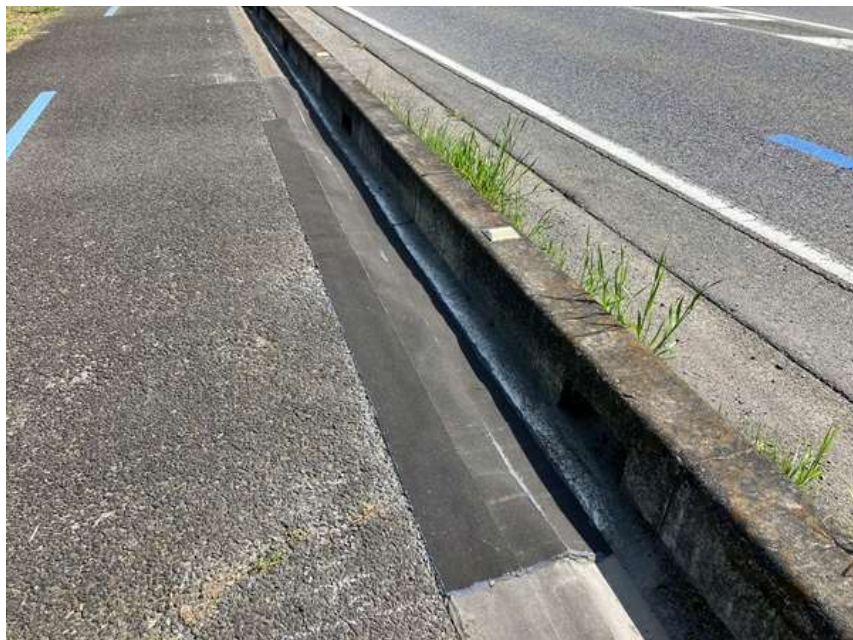
施工事例（滋賀県）
