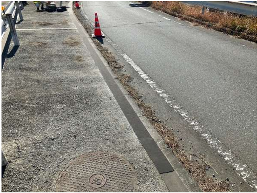
施工事例（山梨県）
