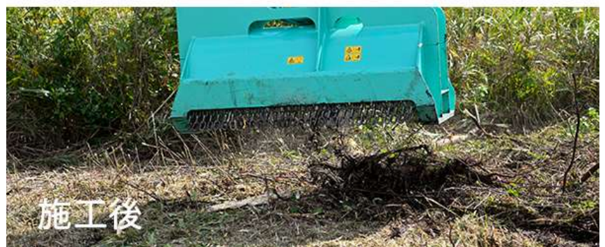
雑木の伐採状況（施工前と施工中、施工後）
