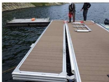
②可変式浮棧橋可変完了
