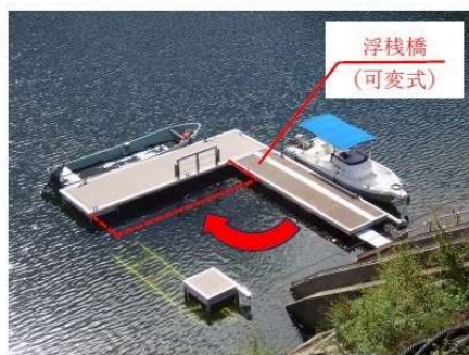
可変式浮棧橋平常時
