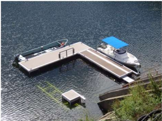
4. ワイヤーガイドにワイヤーを取りつけて、浮棧橋設置完了
