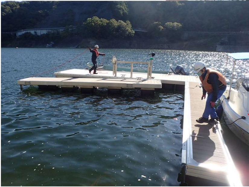
インクライン併設型浮棧橋動作実験状況
