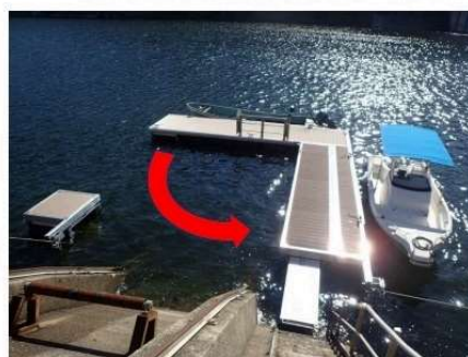
④可変式浮棧橋平常時に復旧
