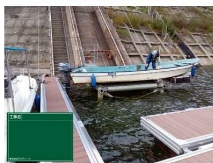
可変式浮棧橋概要説明（船舶昇降に伴う浮棧橋可変の流れ）
