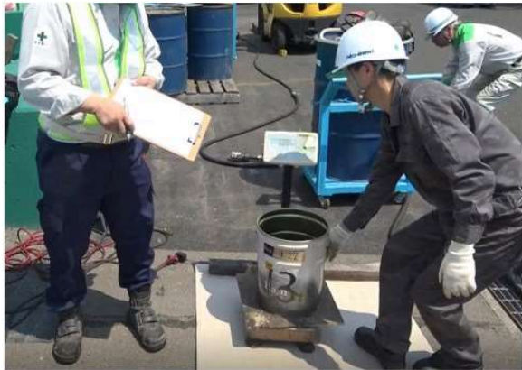
乳剤計量状況
