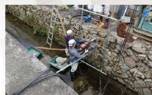
バットレスアンカー施工
