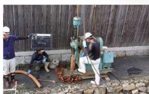
柱状構造体施工
