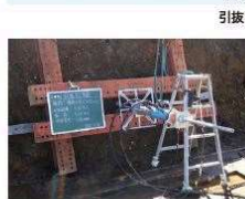
引抜実験状況
