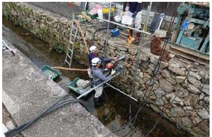
バットレスアンカー施工状況
