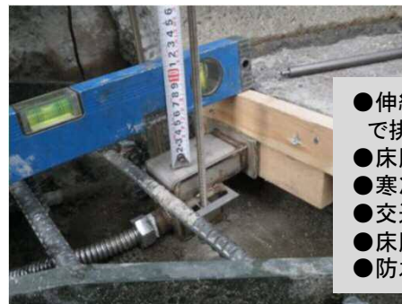
設置例(高さ確認)
