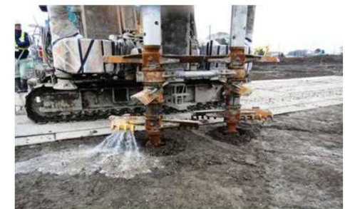
新型攪拌翼とエジェクター吐出口
