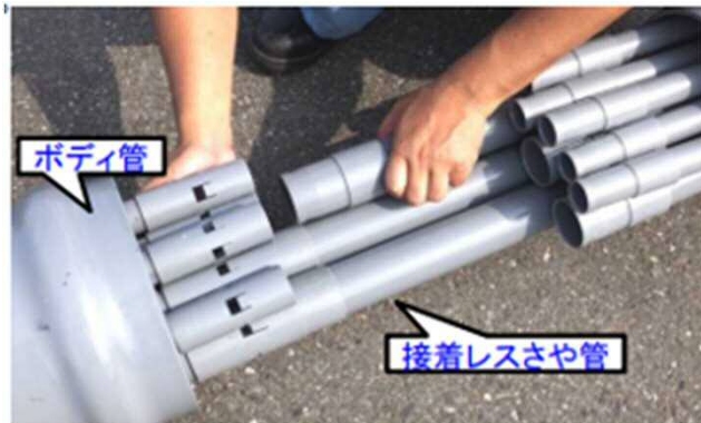
ボディ管内さや管接続作業
