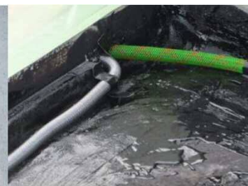
導水管設置例
