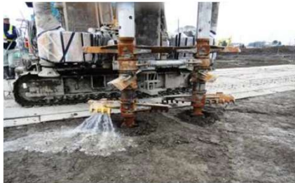
新型攪拌翼とエジェクター吐出口
