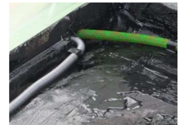
導水管設置例
