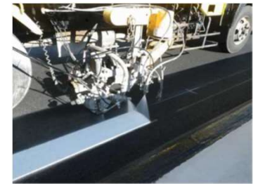
施工状況接写
