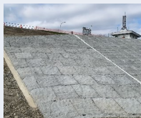
護岸ブロック
