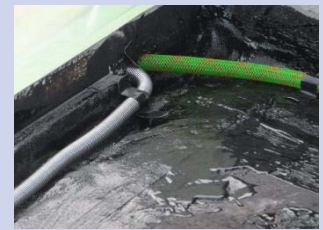
導水管設置例
