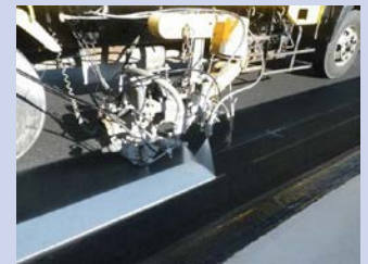
施工状況接写
