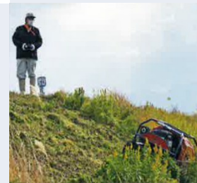
除草作業状況
