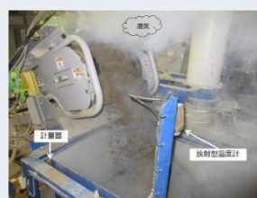
蒸気による骨材の加温状況
