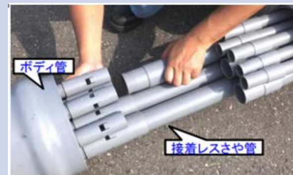
ボディ管内さや管接続作業
