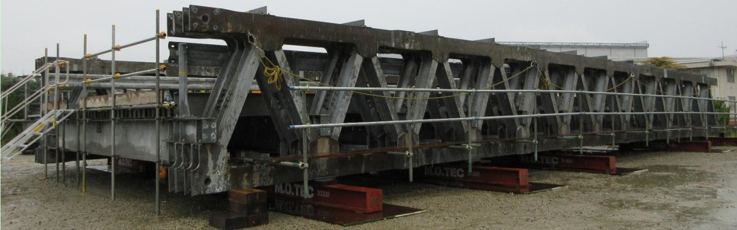
応急組立橋（トラス式 TL-25）
