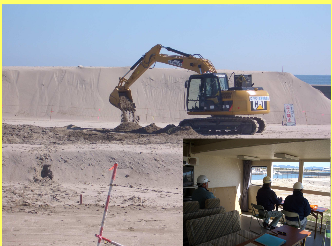
遠隔操縦装置(バックホウ用)訓練状況(H24年度)
