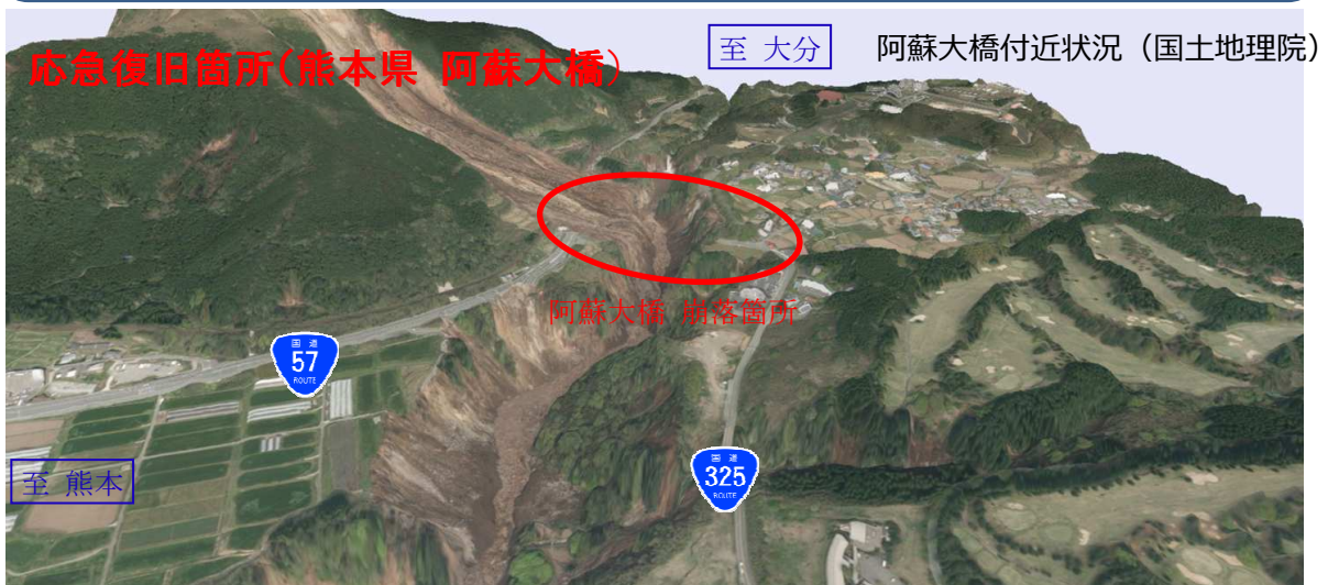
無人化施工状況（阿蘇大橋）
