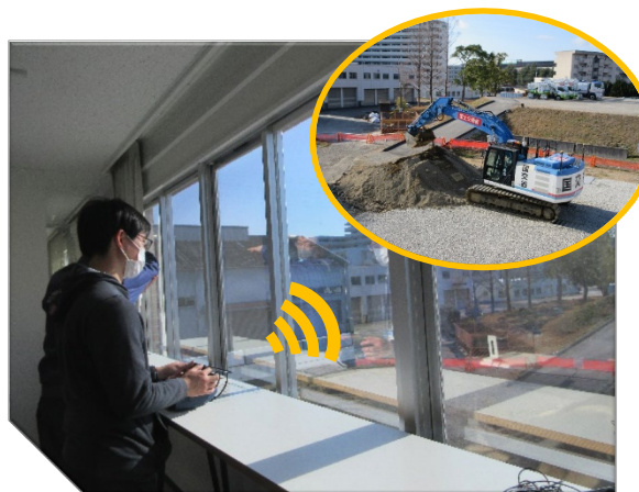
無人化施工体験 (遠隔操縦体験)
