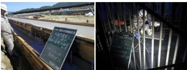
写真-3 施工状況
