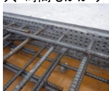
写真-16 施工状況
