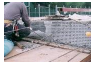
写真-15 取り剥がし状況
