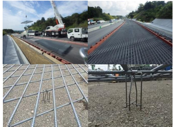
写真-4 連続鉄筋コンクリート舗装用斜交メッシュパネル
