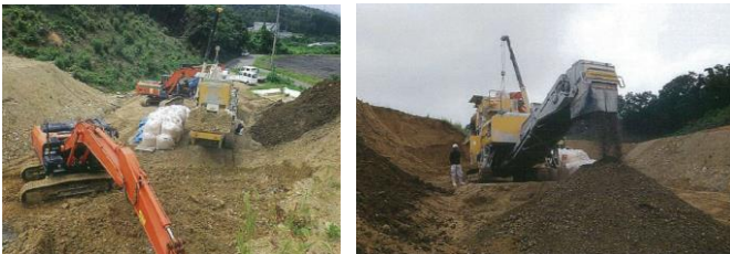
写真-7 施工状況
