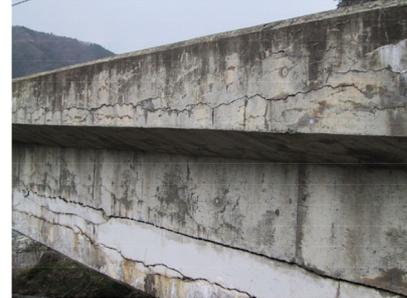
写真-11 ASRにより劣化したPC橋
