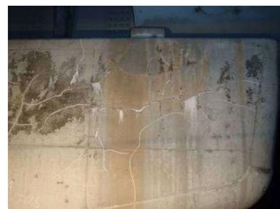
写真-12 ASR を生じた RC 橋脚
