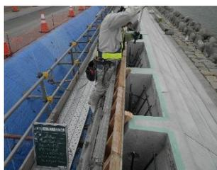
写真-8 波返ブロック型枠設置
