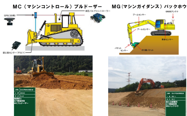
図-15 ICT 機械による施工状況
