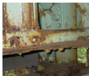
写真-6 対策区分Cの例（腐食）
