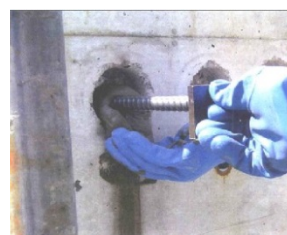
写真-4 ポストヘッドバー設置状況
