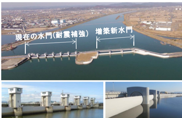
現在の水門(耐震補強) 増築新水門 写真-3 百間川河口水門完成写真
