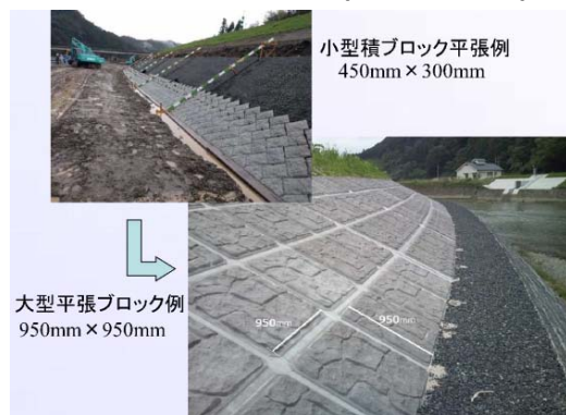
写真-8 大型接続ブロック
