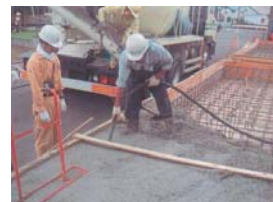
写真-2 施工状況
