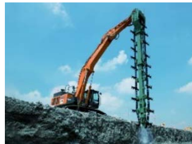
写真-9 パワーブレンダー工法施工機械
