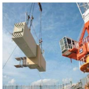
写真-6 柱、梁部の分割化
