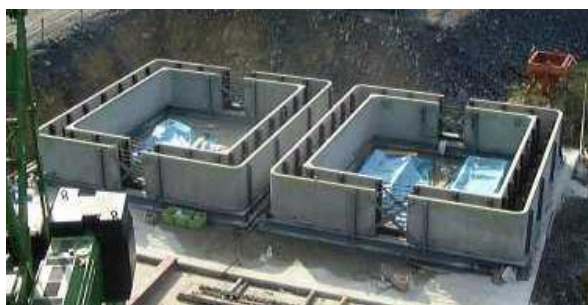
写真-5 埋設型枠工法 (ハーフプレキャスト)
