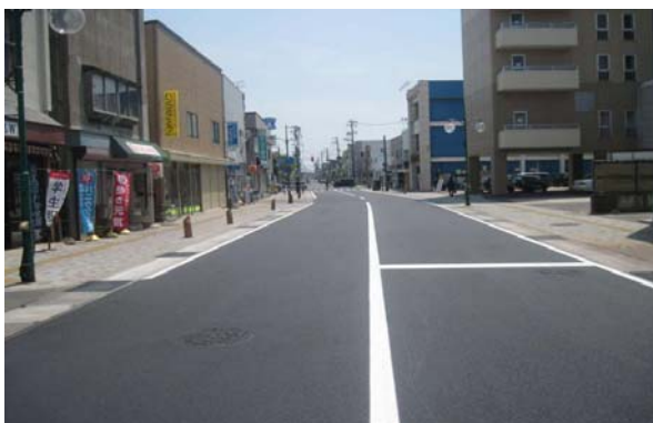
写真-4 施工完了
