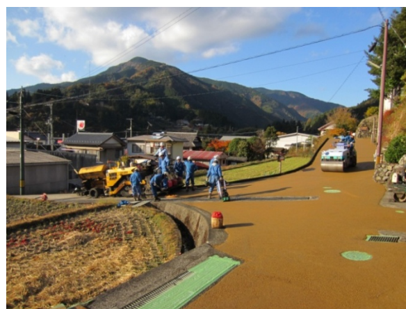
写真-10 施工状況
