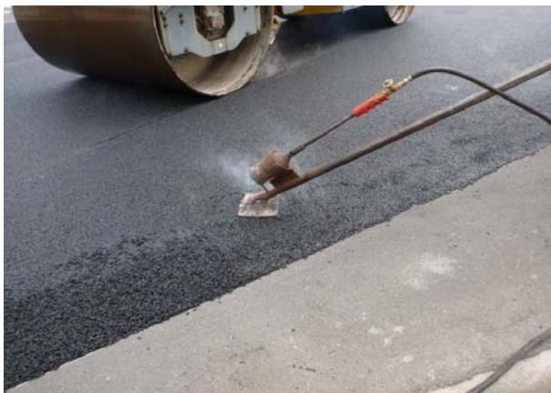
写真-3 端部仕上げ状況
