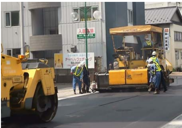
写真-2 施工状況
