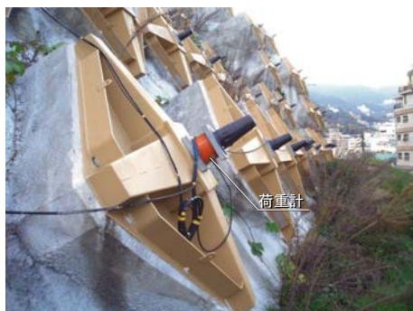
写真-3 荷重計によるアンカー緊張力計測
