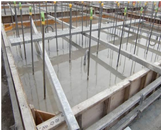
写真-4 ゲル散布完了後の状況 (CASE①)
