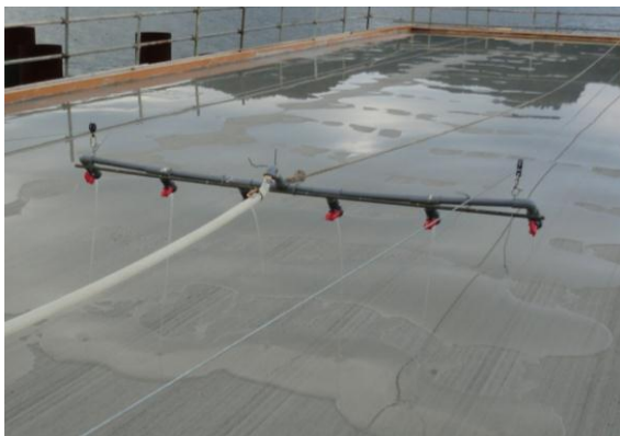
写真-5 ゲル散布状況 (CASE②)
