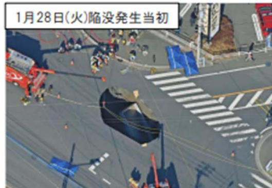
1月28日(火)陥没発生当初
