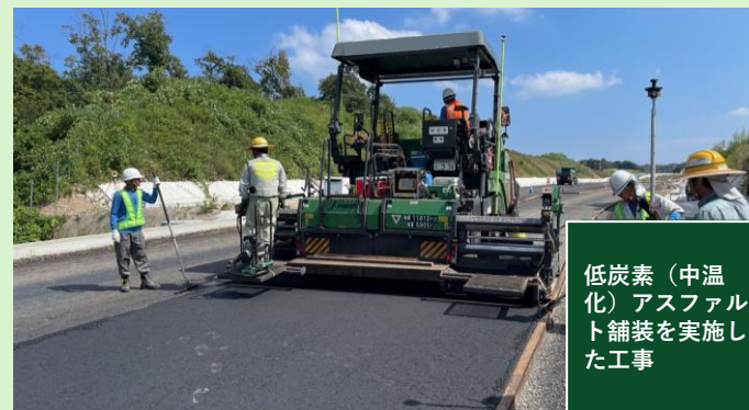
工事名：令和4年度静岡仁摩道路静岡地区舗装工事
