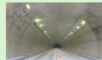
一般国道9号仁摩トンネル
