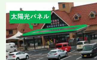
道の駅「キララ多伎」 自動車駐車场上屋
