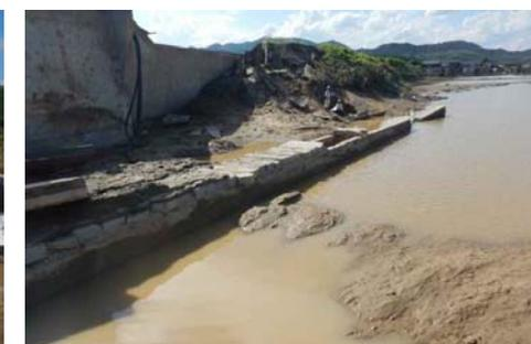
⑥橋梁背面の洗掘状況 7月9日撮影
