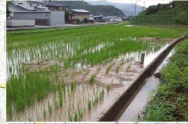
【基盤漏水】L=303m 吉井川右岸14k400付近
