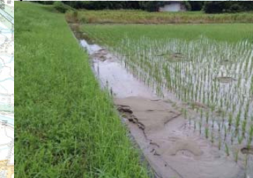
【基盤漏水】L=221m 吉井川右岸8k400付近
