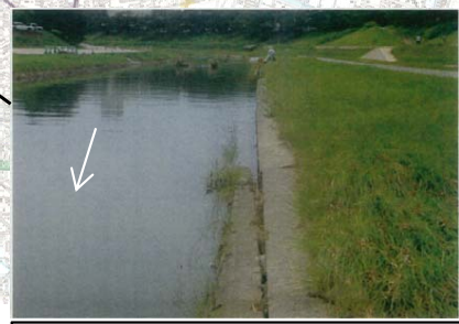
【護岸損壊】L=80m 旭川左岸8k600付近
