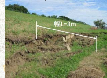
【裏法崩れ】L=210m 吉井川右岸13k200付近
