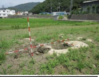
【基盤漏水】L=126m 吉井川右岸21k600付近
