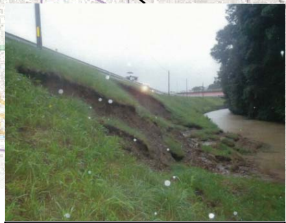
【裏法崩れ】L=30m 旭川右岸17k100付近
