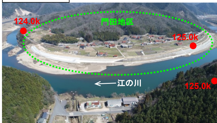
堤防整備状況
