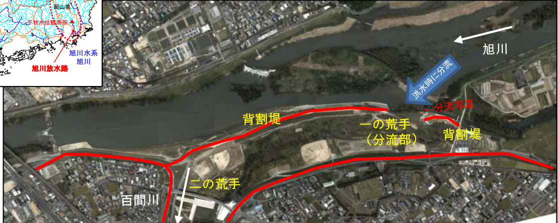
旭川放水路(百間川) 分流部
