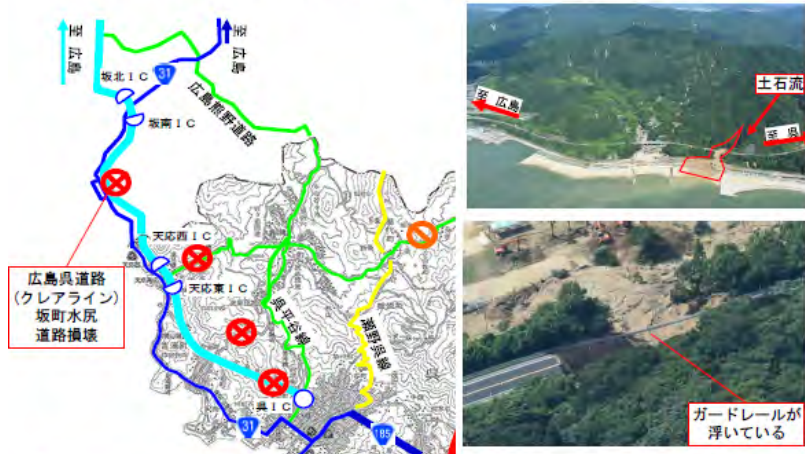
(1) 広島呉道路(クリアライン) 坂町水尻 道路損壊
