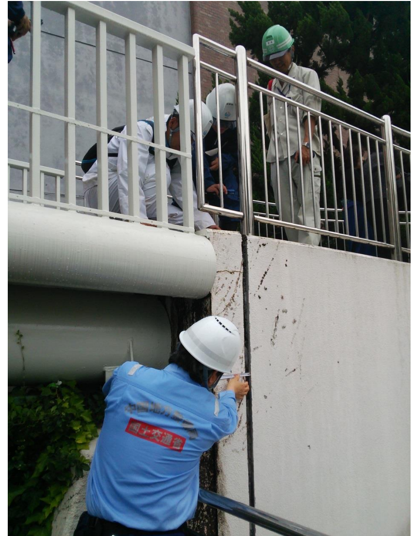
被災状況調査(枚方市駅前横断歩道橋)
