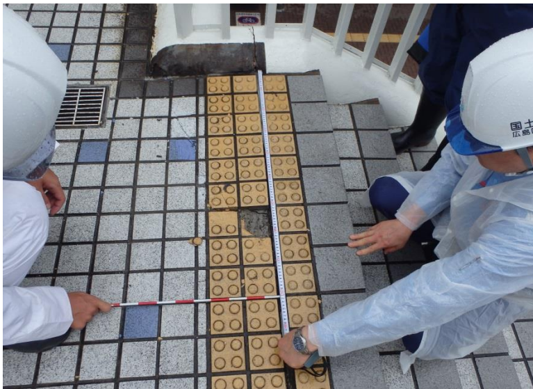
被災状況調査(枚方市駅前横断歩道橋)
