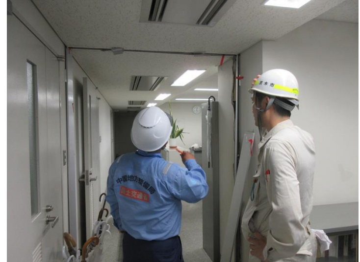
被災状況調査
