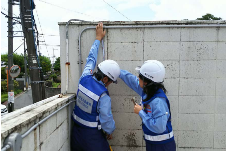
被災状況調査(茨木市内)
