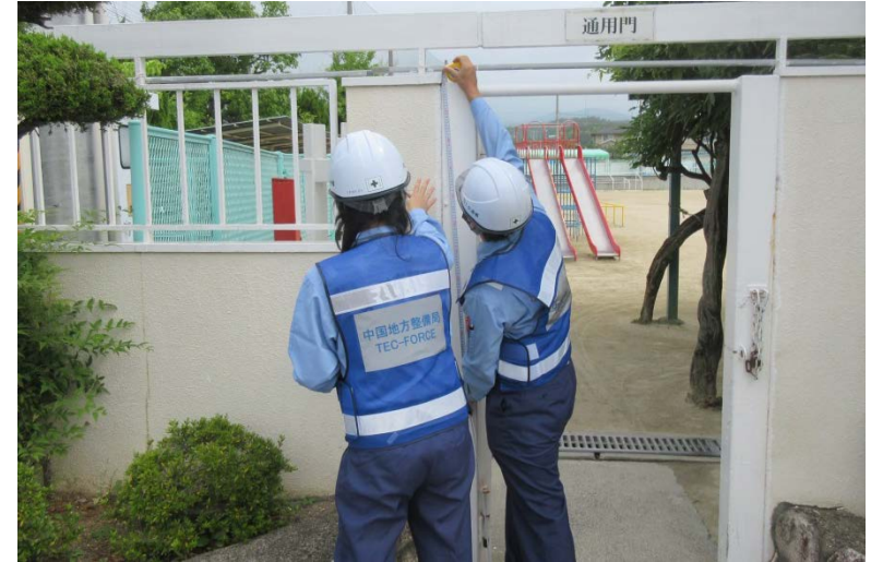
被災状況調査(茨木市内)
