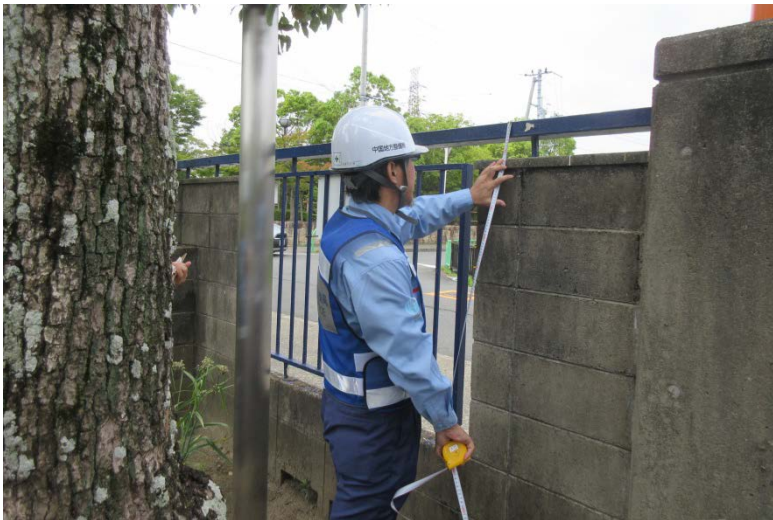
被災状況調査(茨木市内)
