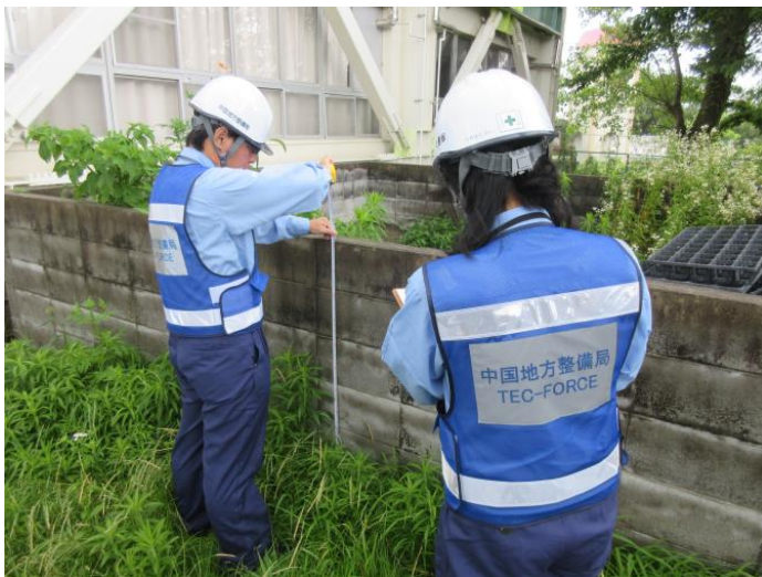
被災状況調査(茨木市内)
