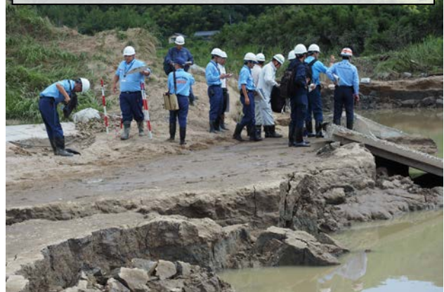
決壊箇所現地調査（小田川左岸 6k400 付近）
