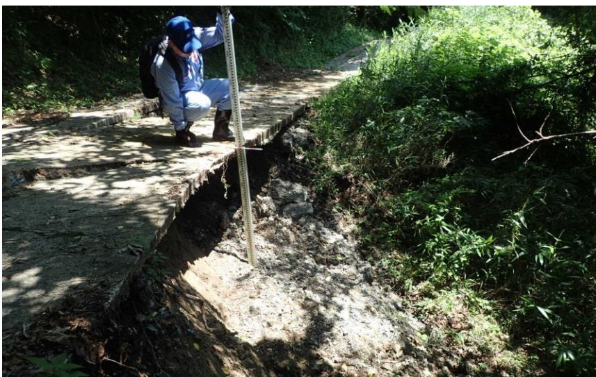
被災状況調査(神石高原町)
