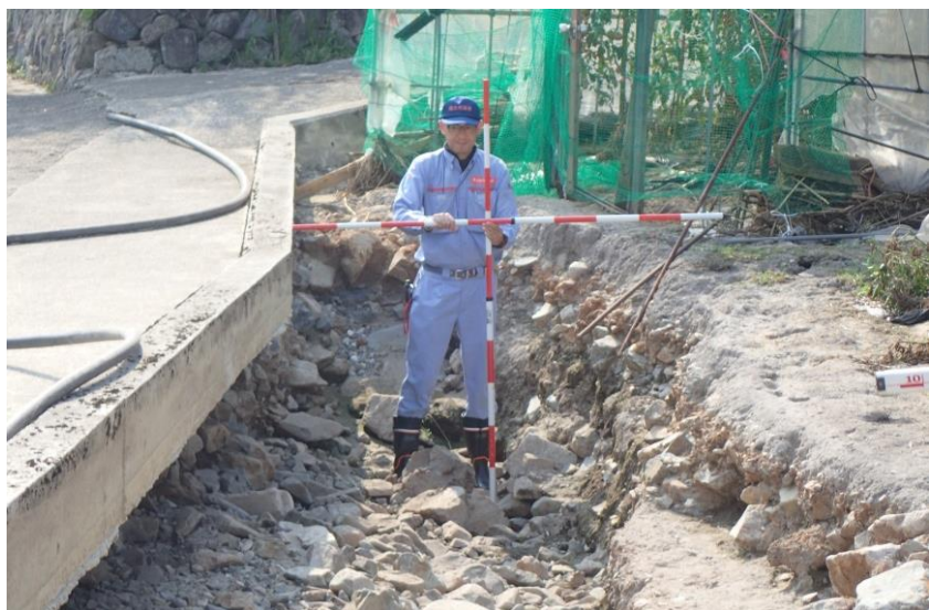
被災状況調査(神石高原町)
