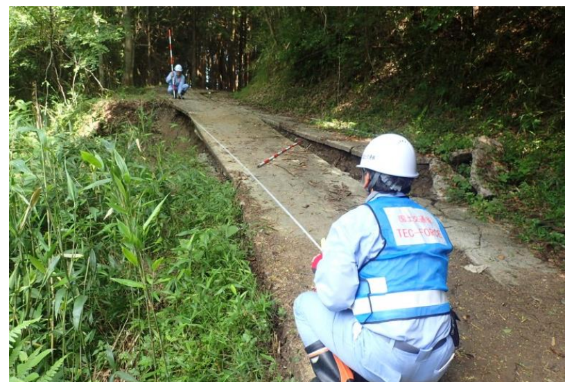
被災状況調査(神石高原町)
