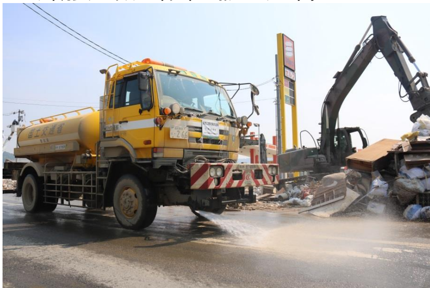
散水作業中（倉敷市真備町）
