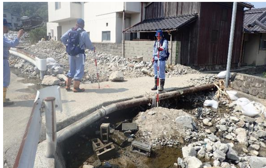
被災状況調査(広島市)
