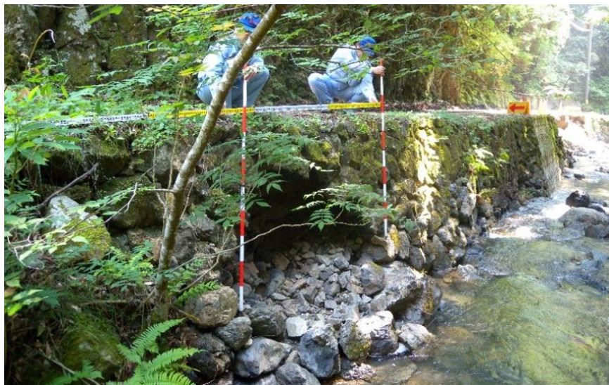
被害状況調査(新見市)
