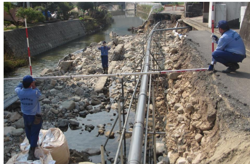
被災状況調査(広島市)
