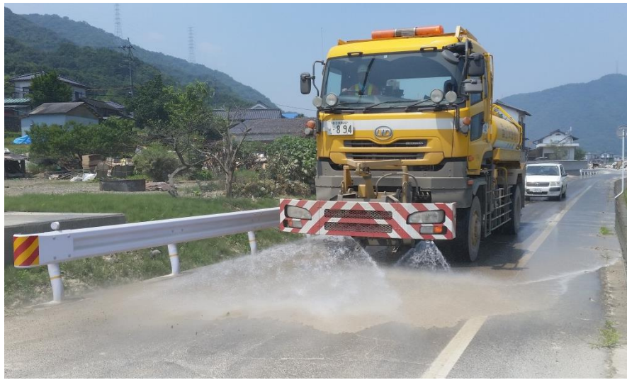
路面高圧洗浄（倉敷市真備町）
