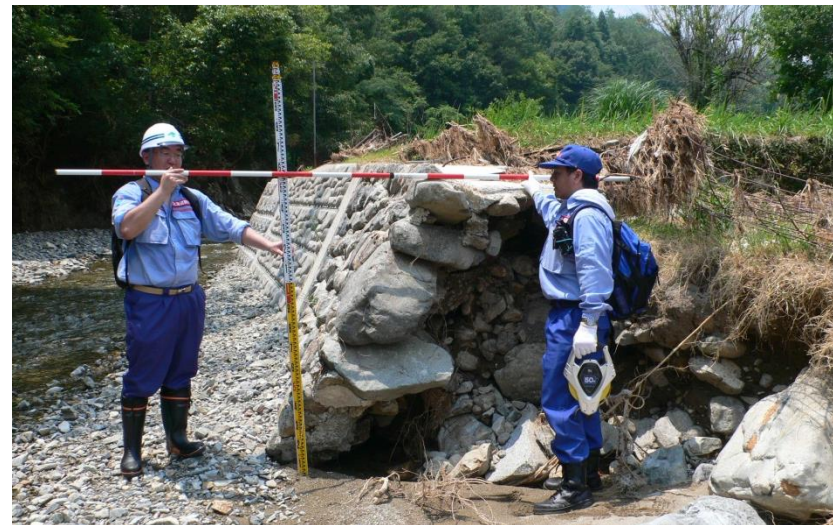
被災状況調査(広島市)
