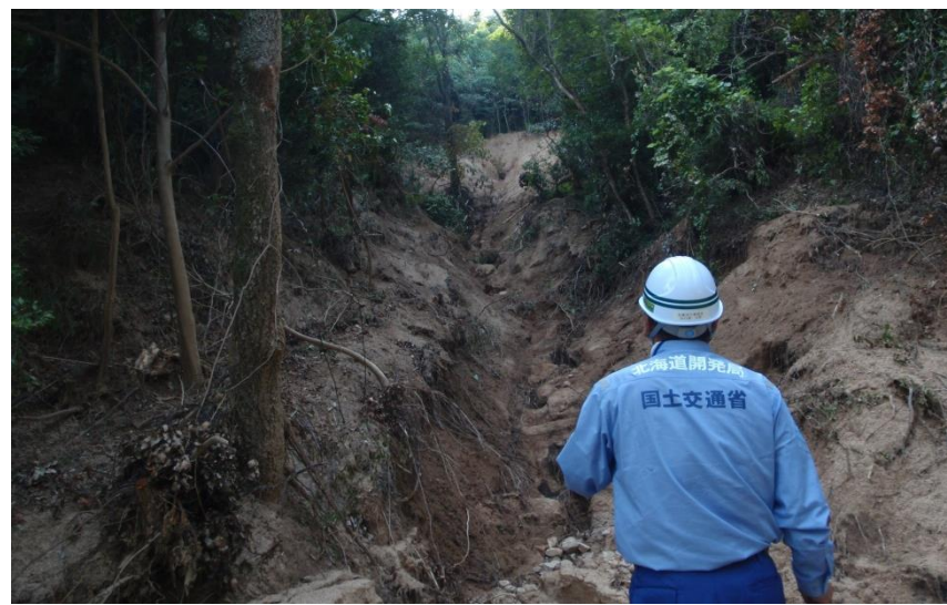
被災状況調査(呉市)
