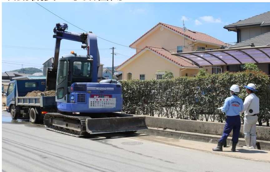
水路啓開作業（倉敷市真備町）
