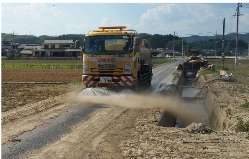
散水作業(倉敷市真備町)
