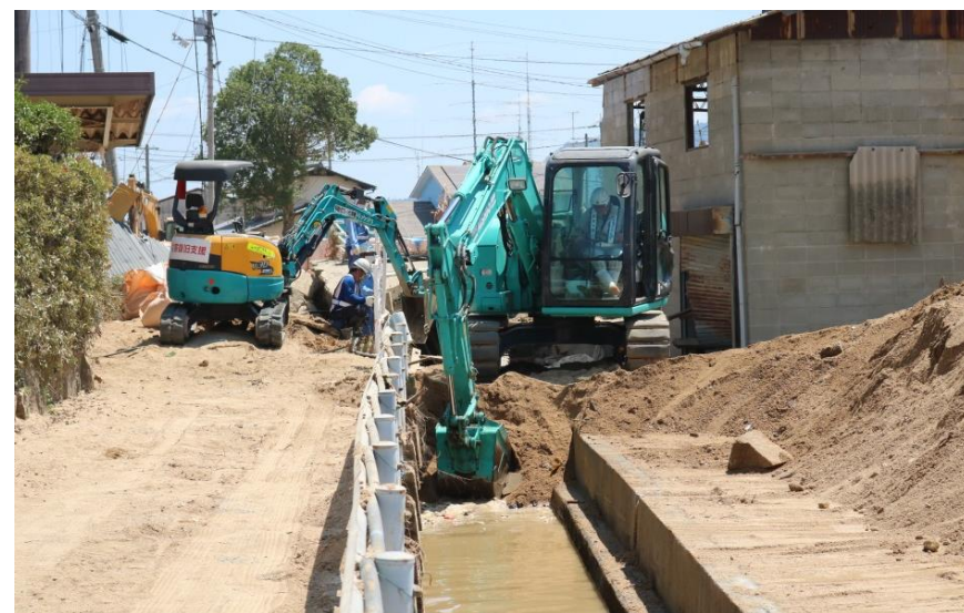
水路啓開作業（倉敷市真備町）
