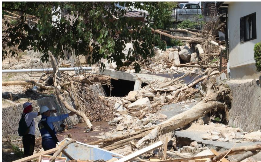
道路啓開(呉市天応)
