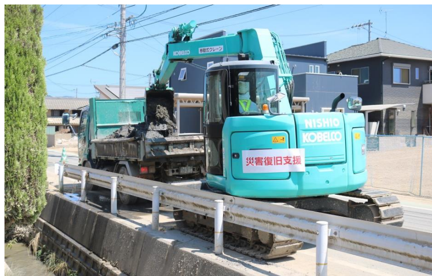
水路啓開作業（倉敷市真備町）
