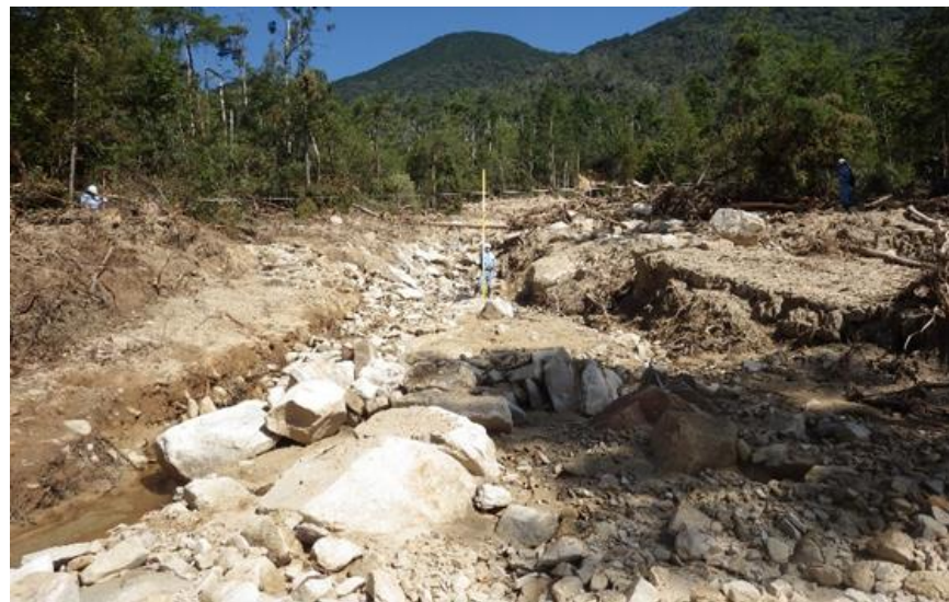
被災状況調査(東広島市)
