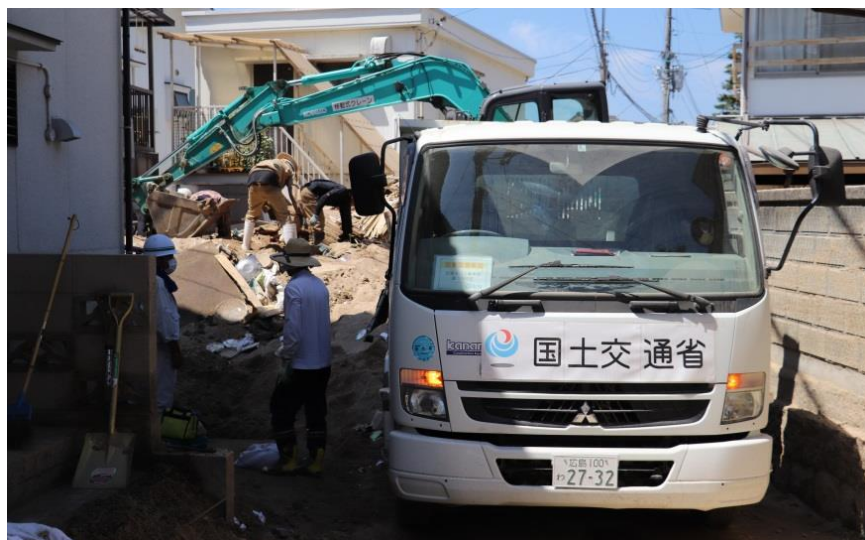
道路啓開(安芸郡坂町小屋浦)
