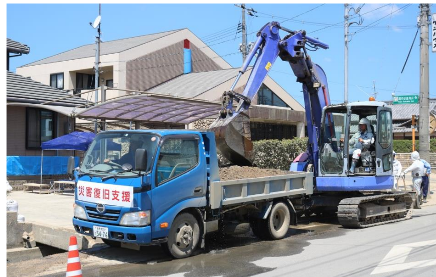
水路啓開作業（倉敷市真備町）
