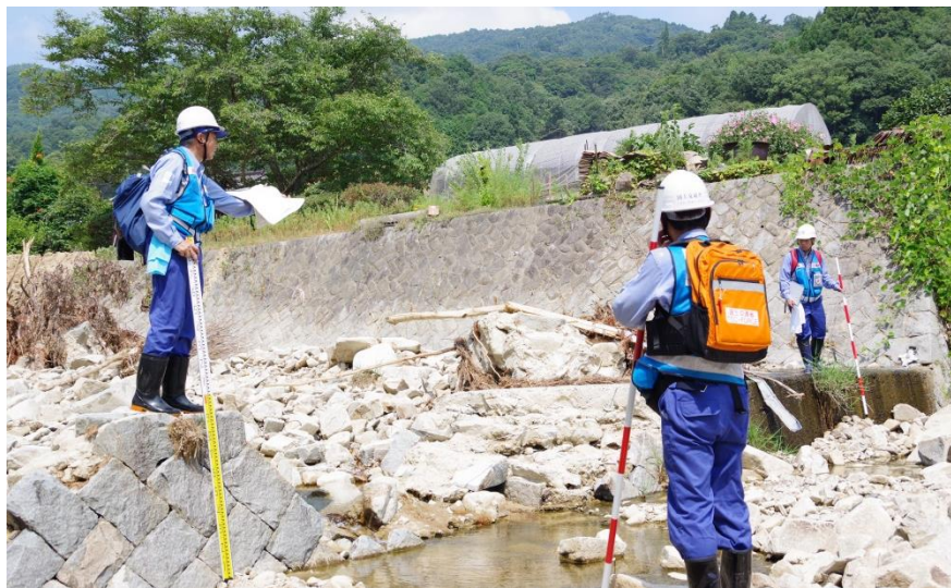
被災状況調査（呉市）
