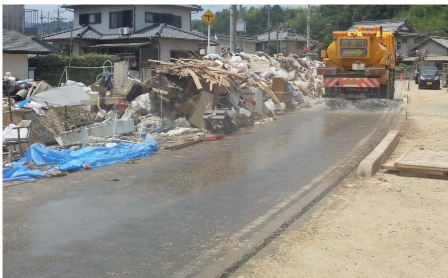
散水作業後（倉敷市真備町）
