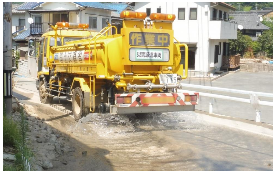
散水作業（坂町※H30.7.25）
