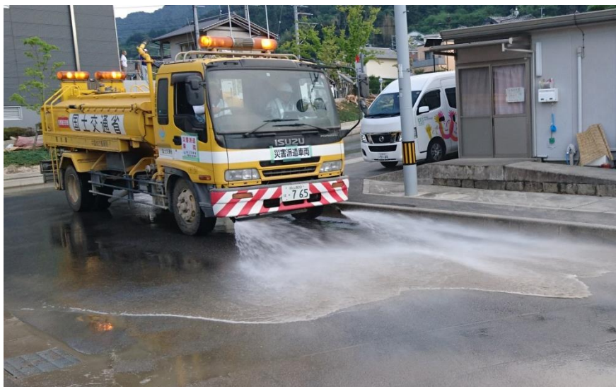
散水作業（坂町※H30.7.23）
