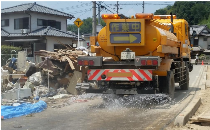
散水作業（倉敷市真備町）
