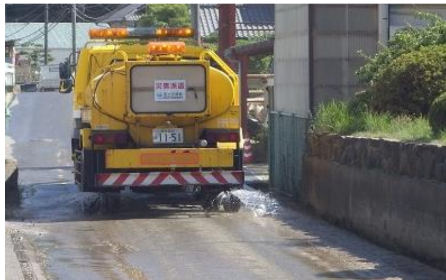
散水作業（三原市※H30.7.23）
