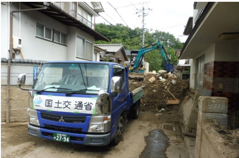
道路啓開（坂町小屋浦）
