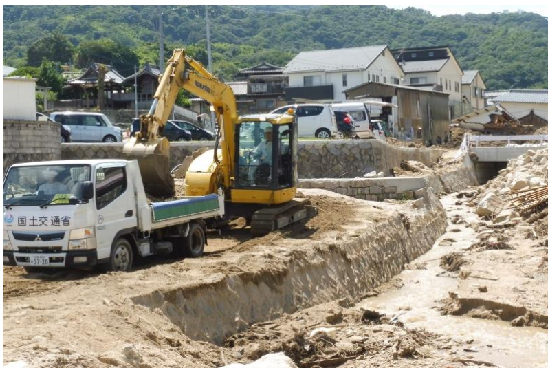
土砂撤去作業（坂町坂西）
