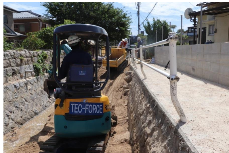
河川土砂撤去（呉市天応）
