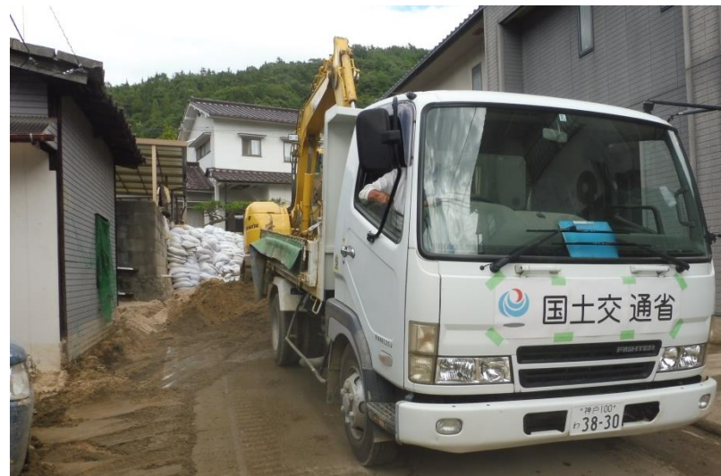
道路啓開（坂町小屋浦）
