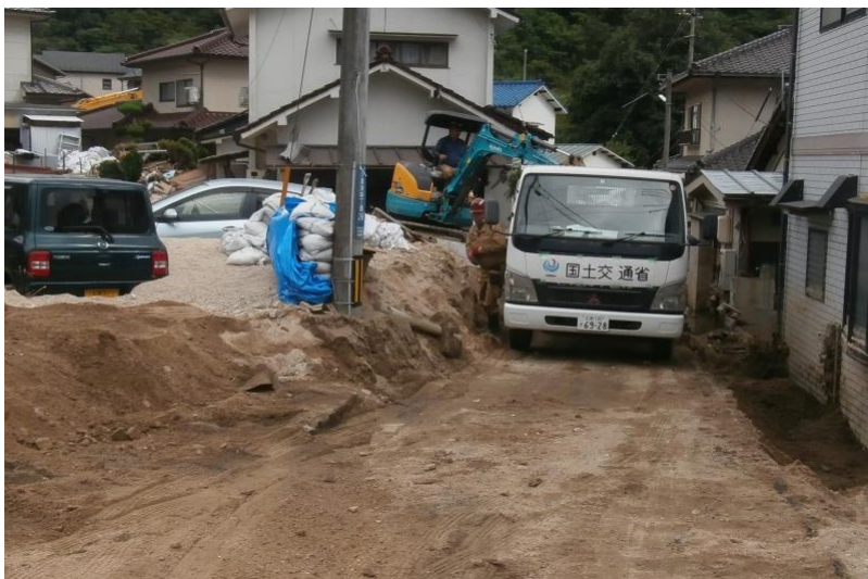
道路啓開（坂町小屋浦）
