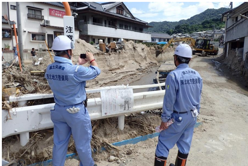
現地状況確認（坂町坂西地内）
