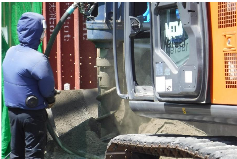
防護柵設置作業（尾道市美ノ郷）
