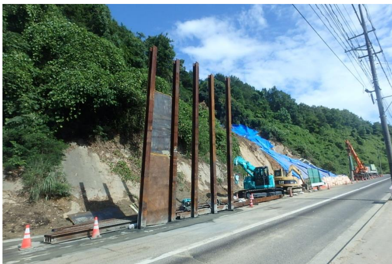
防護柵設置作業（尾道市美ノ郷）
