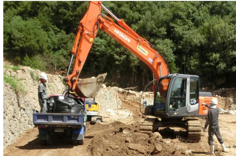
道路啓開作業（三原市木原※H30.7.29）
