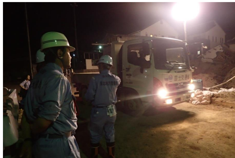
夜間作業確認（坂町坂西地内）
