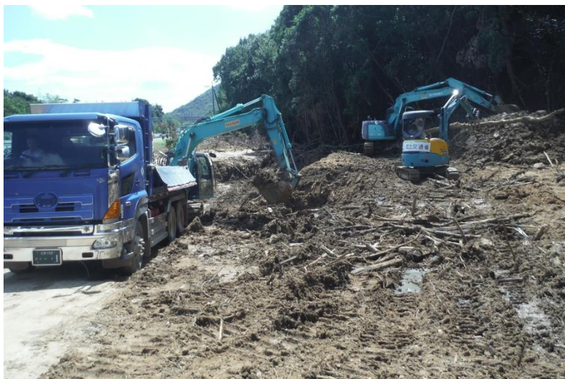
道路啓開作業（東広島市高屋地内）
