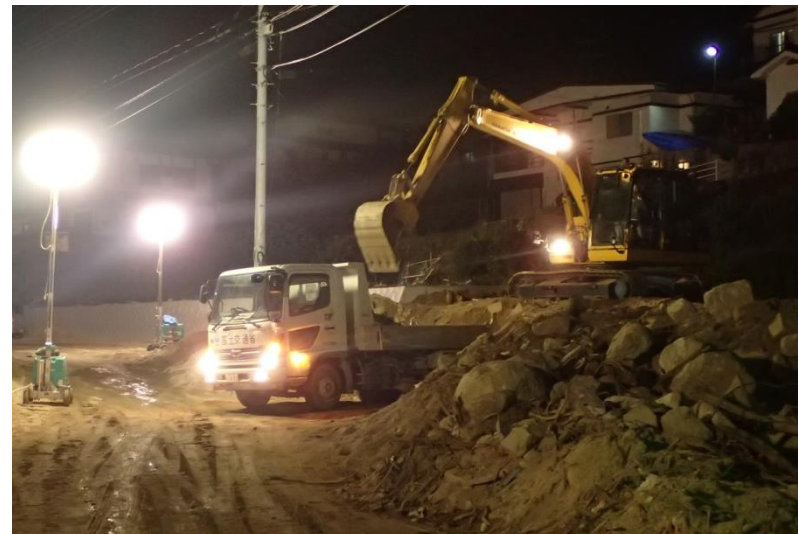
土砂撤去作業（坂町坂西：夜間）
