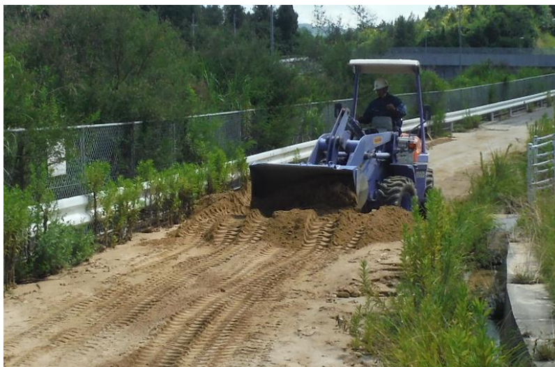
道路啓開作業（東広島市高屋地内）
