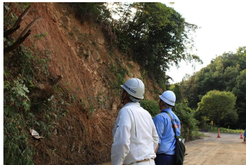
崩落のり面状況確認（福山市郷分）
