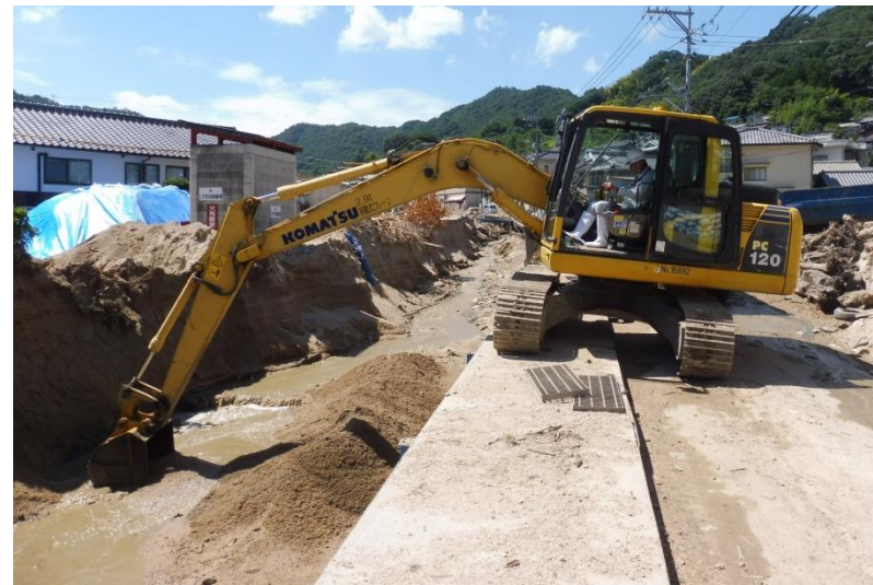
土砂撤去業（坂町坂西）
