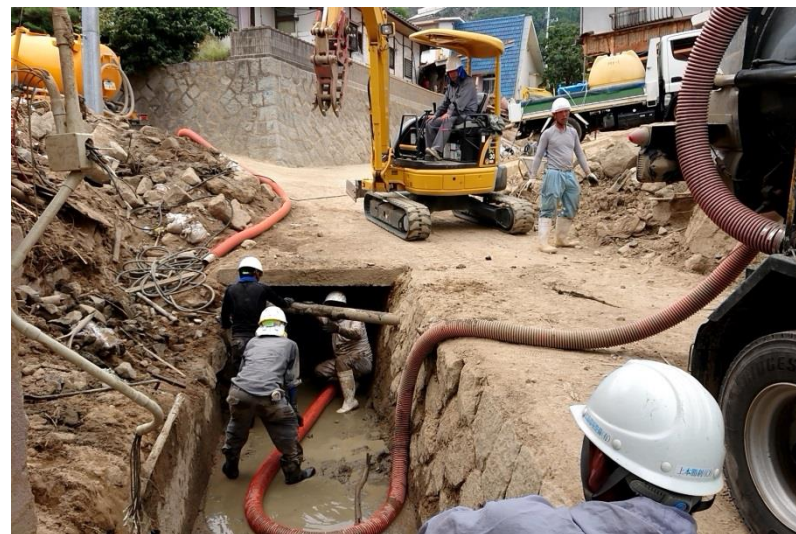
土砂撤去業（三原市木原※H30.7.28）
