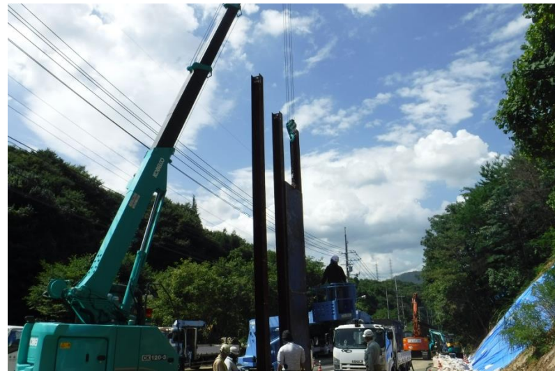
防護柵設置作業（尾道市美ノ郷）
