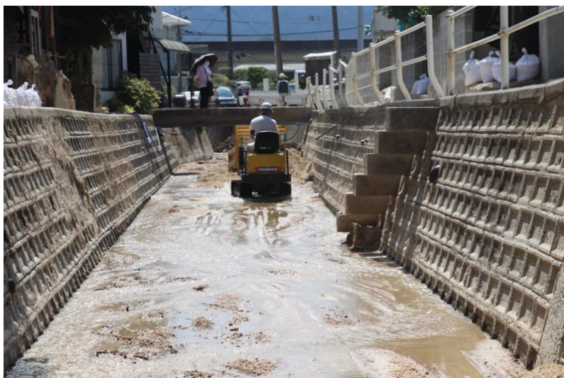
河川土砂撤去（呉市天応）
