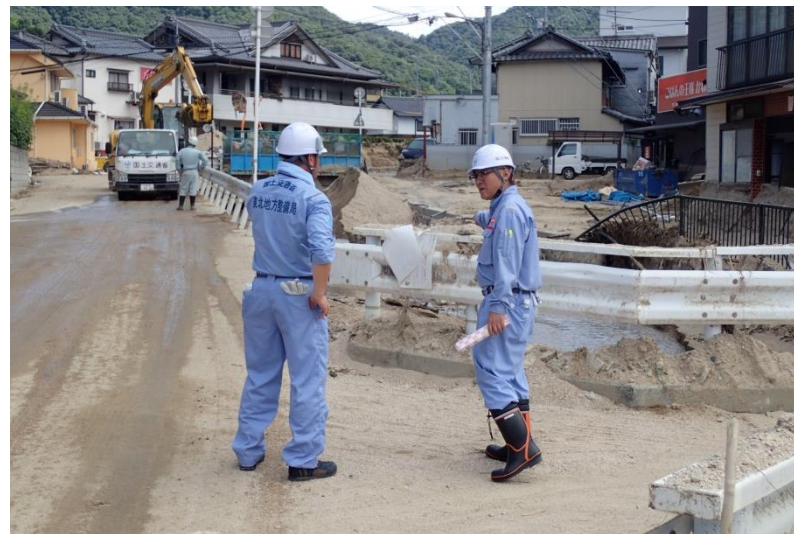
現地状況確認（坂町坂西地内）
