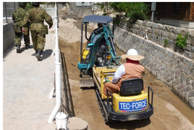
河川土砂撤去（呉市天応）
