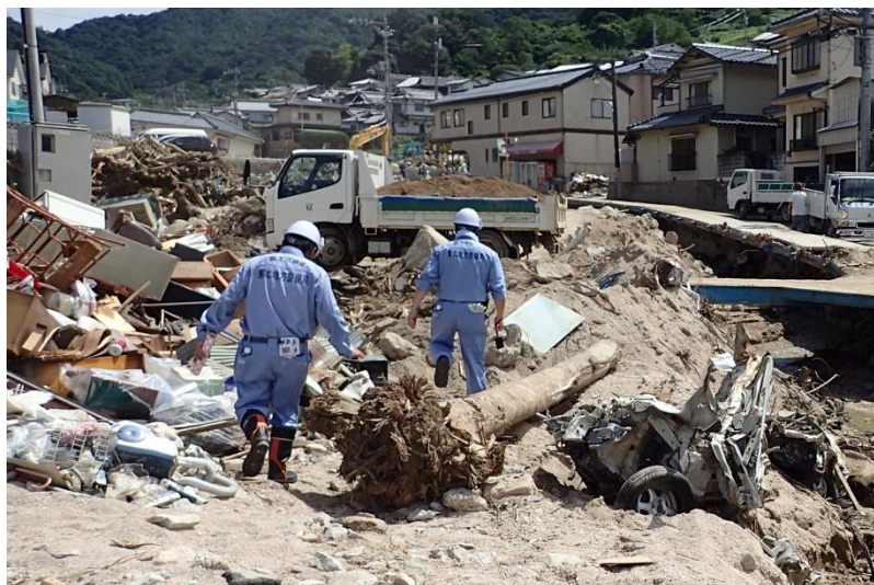
現地状況確認（坂町坂西地内）
