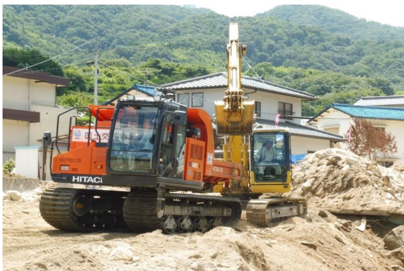
土砂撤去作業（坂町坂西）
