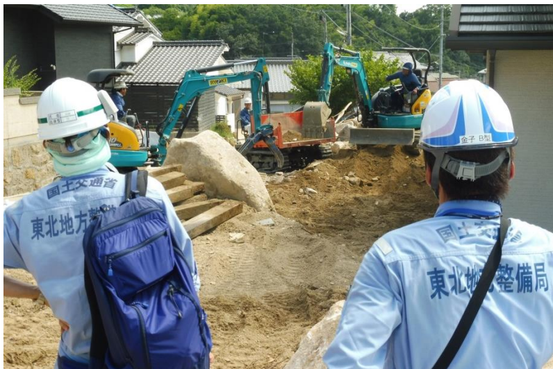
道路啓開（呉市天応）
