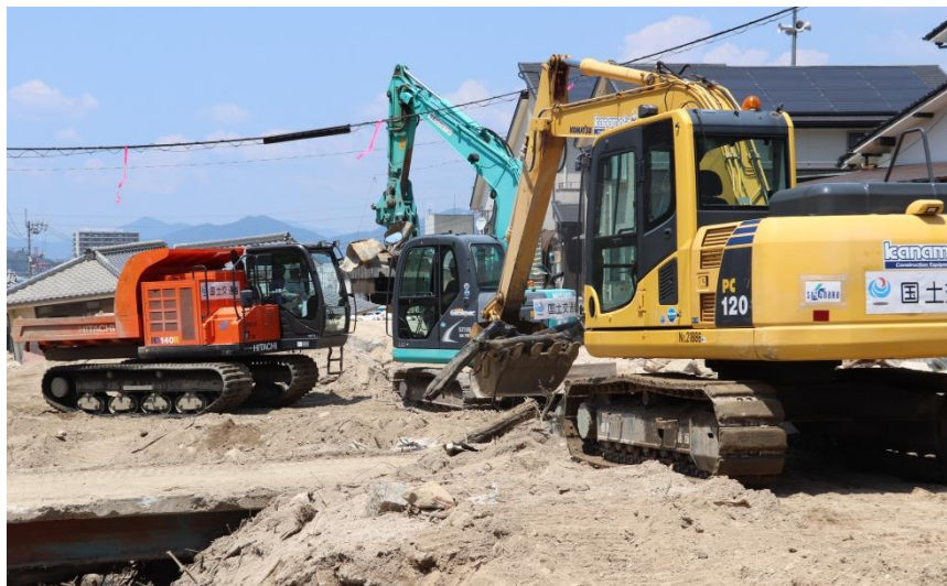
土砂撤去作業（坂町坂西）
