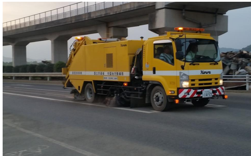
清掃作業（倉敷市真備町）
