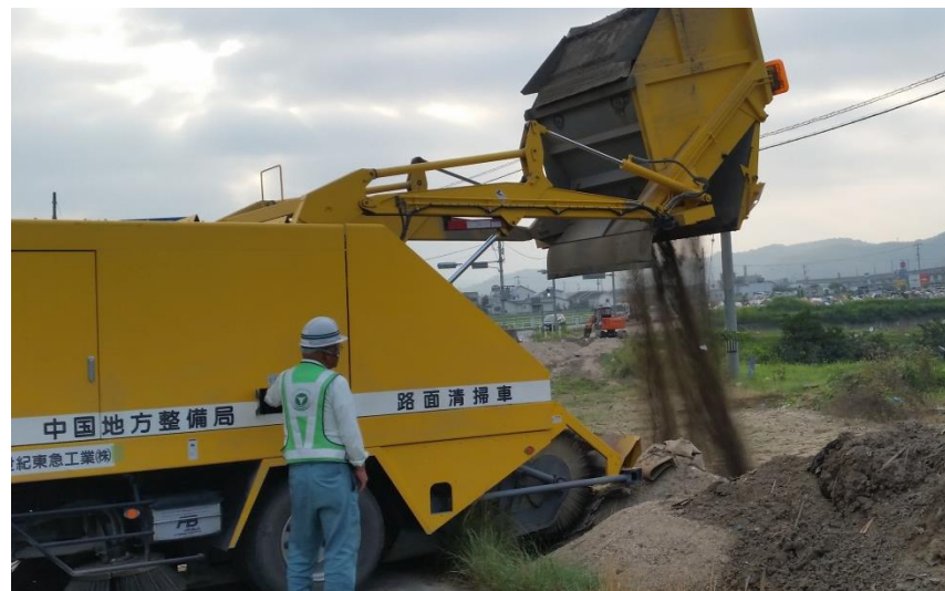
清掃作業（倉敷市真備町）
