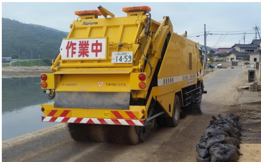
清掃作業（倉敷市真備町）
