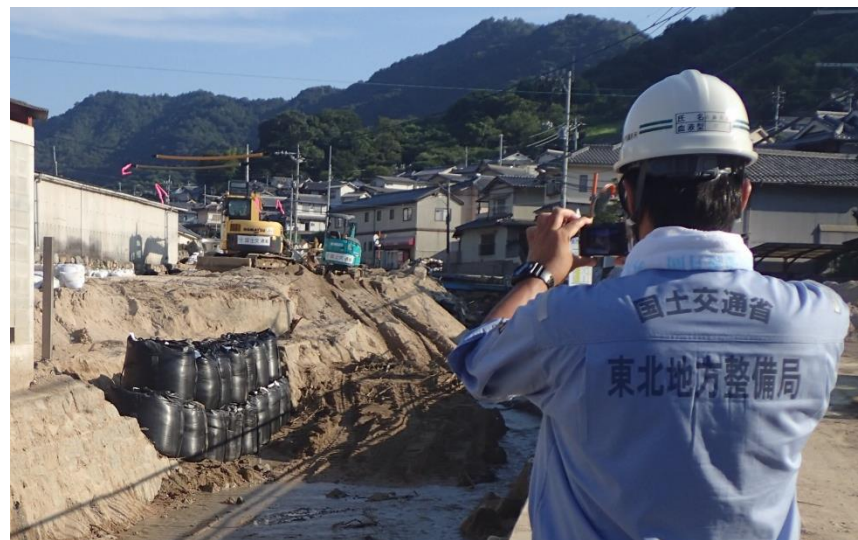
現地状況確認（坂町坂西）
