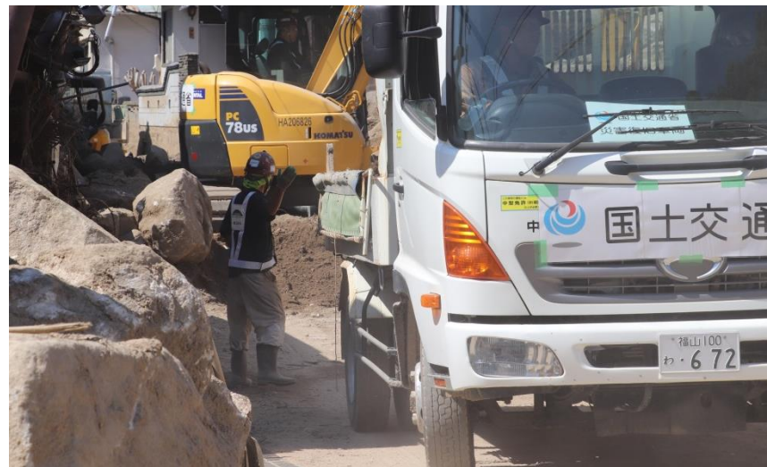
道路啓開（坂町小屋浦）
