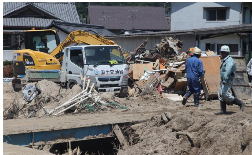
土砂撤去作業（坂町坂西）
