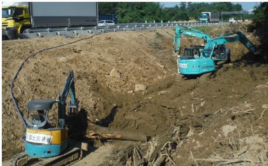
道路啓開作業（東広島市高屋町）
