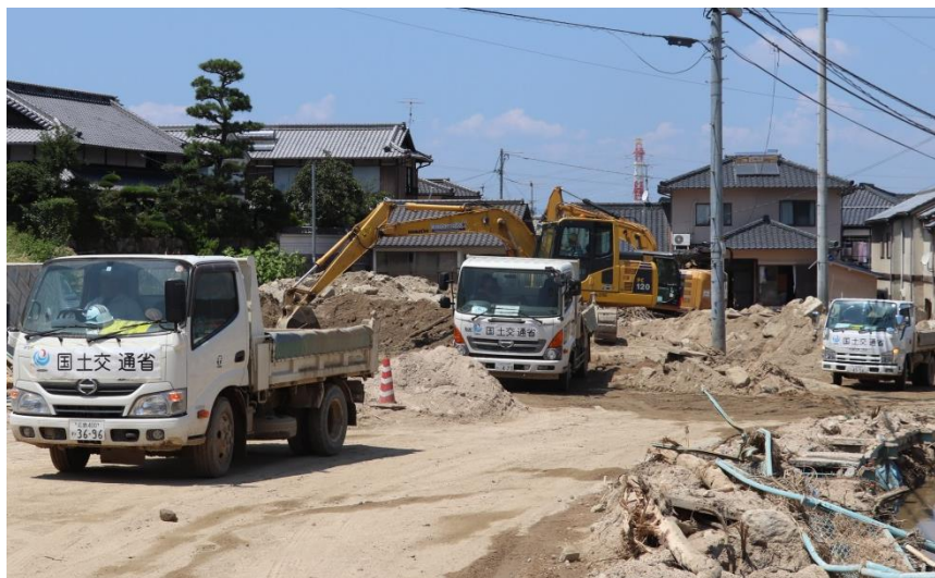
土砂撤去作業（坂町坂西）
