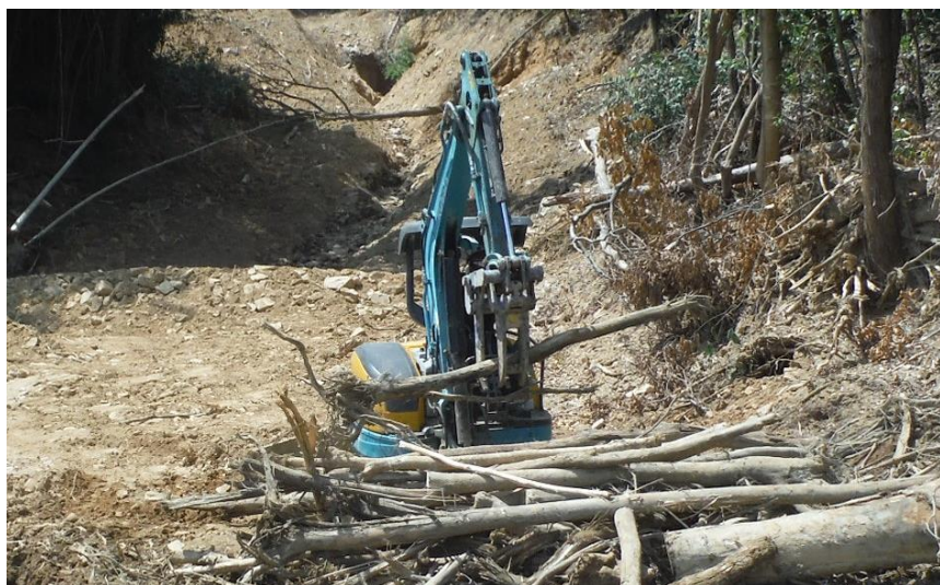
道路啓開作業（東広島市高屋町）
