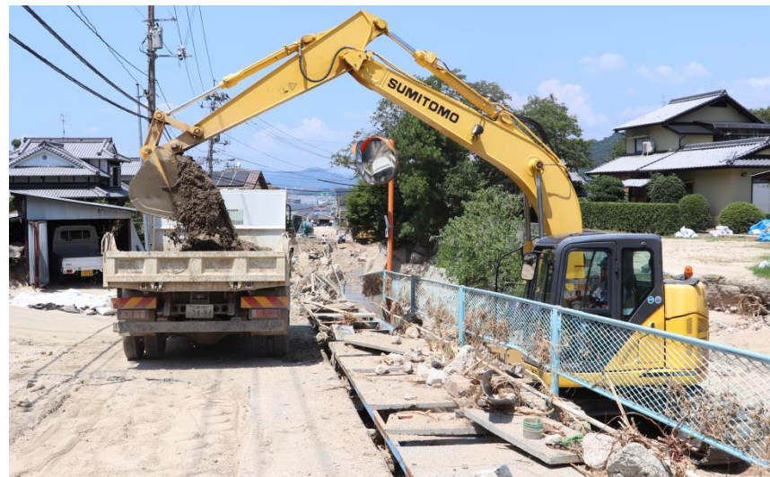
土砂撤去作業（坂町坂西）
