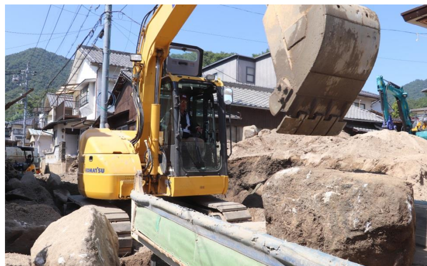
道路啓開（坂町小屋浦）
